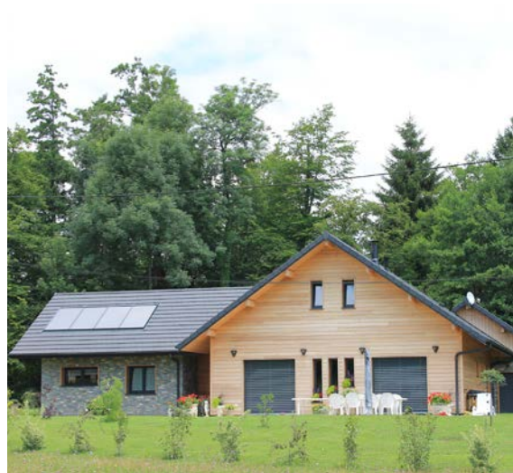
Chauffage solaire sur maison BBC basse consommation
